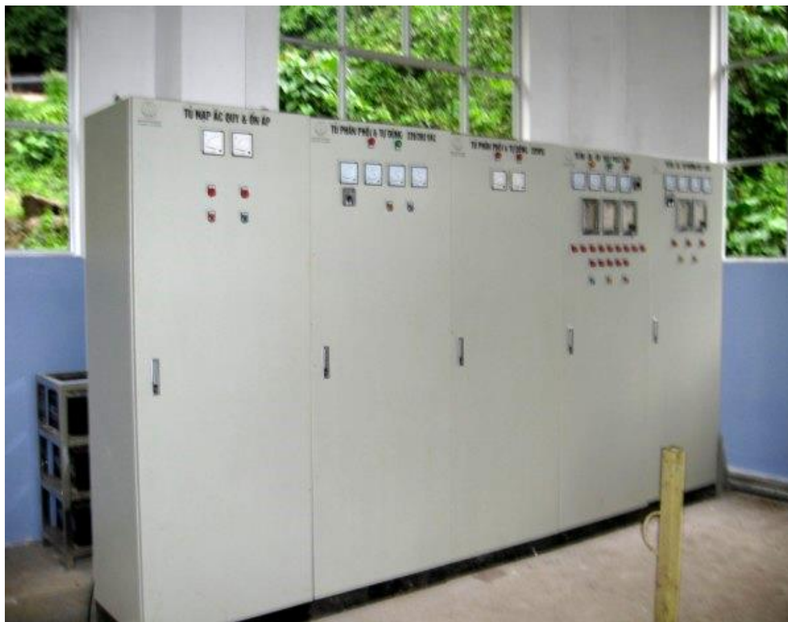
TỦ ĐIỆN ĐỘNG LỰC & ĐIỀU KHIỂN KHÁCH SẠN CANDEO – 287 ĐỘI CÁN - HN
